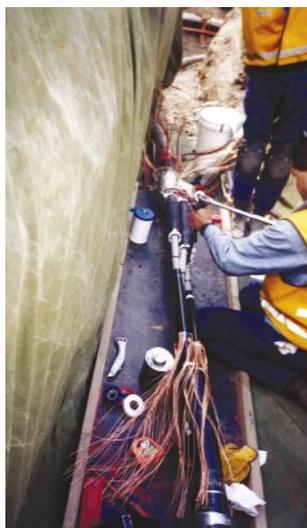
Соединительная муфта типа SOJ 12 кВ с болтовым соединением, Китай.
