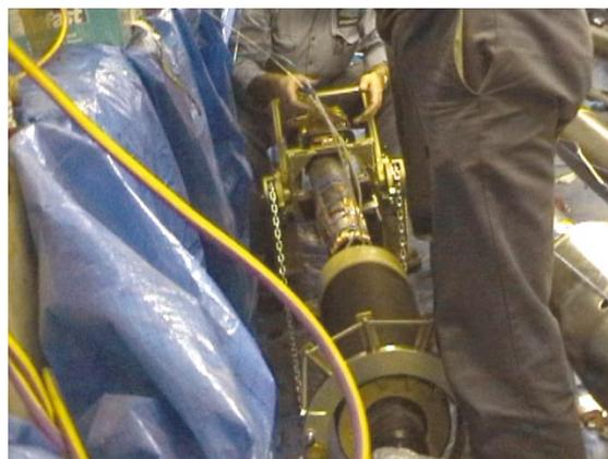
Монтажный инструмент RKM 170 для монтажа муфты SMPGB на кабеле напряжением 170 кВ.
