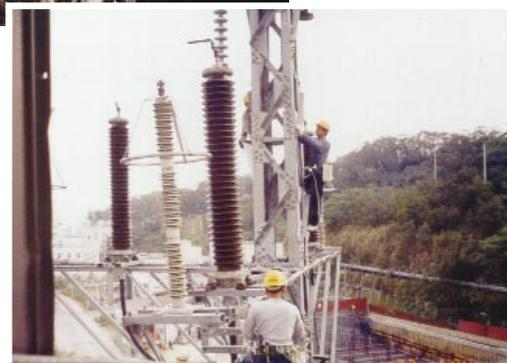
Концевые муфты АРЕС 245 кВ, Тайвань.
