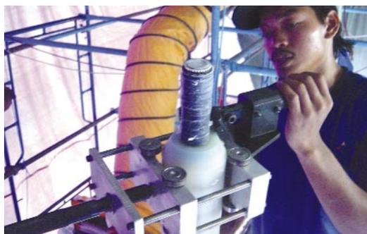
Разделка высоковольтного кабеля с помощью инструмента РКМ 4595 для снятия и сведения на конус СПЭ-изоляции, Малайзия.
