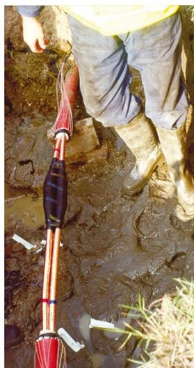
Соединительная муфта типа SOJ 12 кВ для кабеля с ленточным экраном, Австралия.
