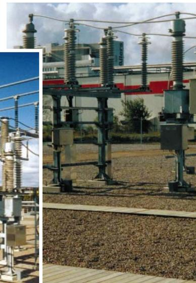
Концевые муфты АРЕСВ-Р 145 кВ с силиконовым изолятором, Швеция.
