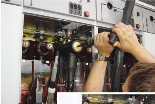
Натяжной адаптер SOC 630 А на выключателе производства АББ типа RGC, Швеция.
