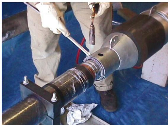
Соединительные муфты SMPGB 170 кВ с транспозицией экранов.
